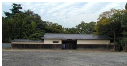
図 3-29 解体前の平野屋新田会所 (出典：大東市 HP)
