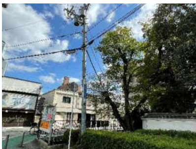
電気関連設備
