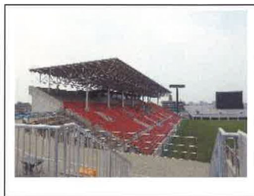
写真2 西側メインスタンド (南より見る)
