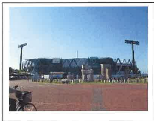
写真1 南側正面入口 外観 (5/14撮影)
