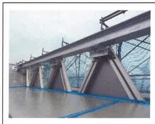
写真4 南面PCaカーテンウォール頂部
