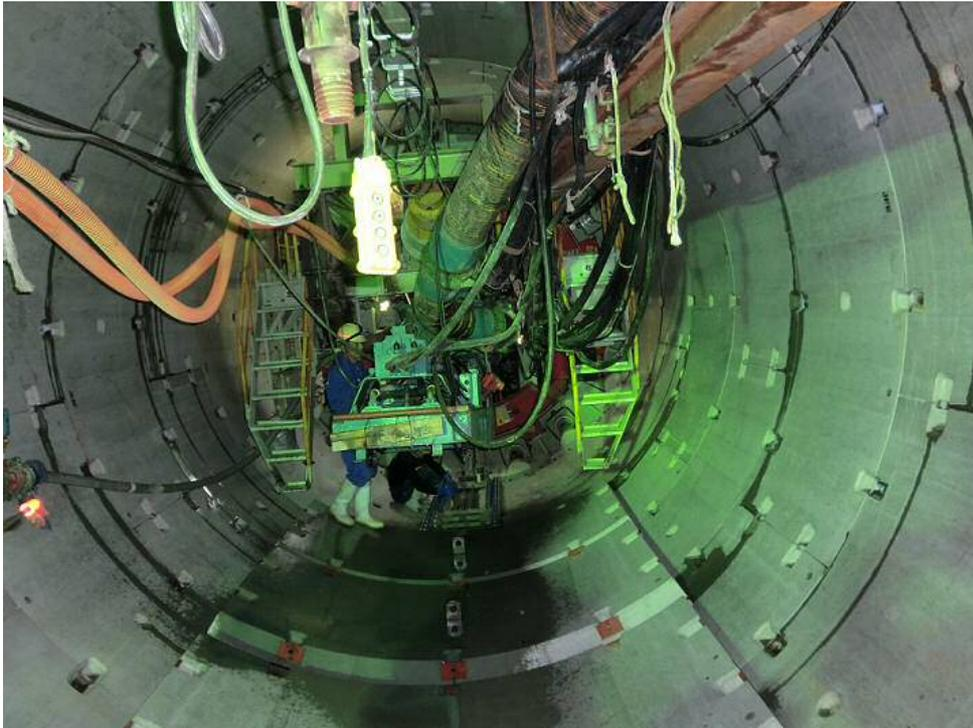
中央上の黄色の円形がスクリーコンベア。手前下に、次に組立てるセグメントが並べられている。
