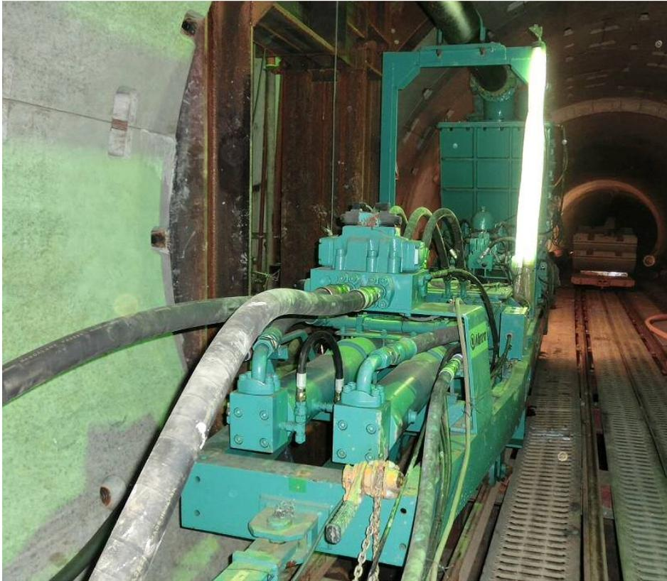
シールド機からの掘削土砂を地上の土砂ピットに圧送する。
