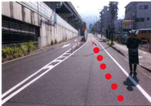
更生管路埋設位置を表示
