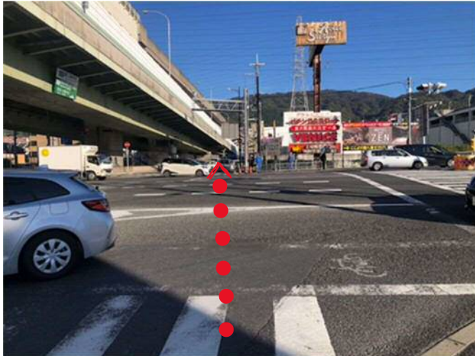
施工箇所の状況-交通量が多い (NO.3 管路更生到達立坑付近)
