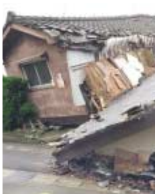
2007年の新潟県中越沖地震で倒壊した家
