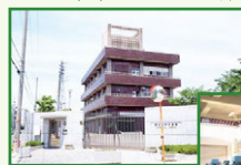
水走配水場 外観
