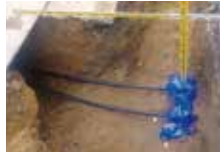
取替え後の給水管(水道用ポリエチレン管)
