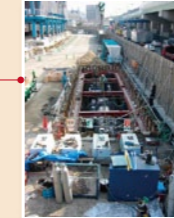
※工事中の写真
