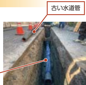
▲ 水道管更新工事の様子
