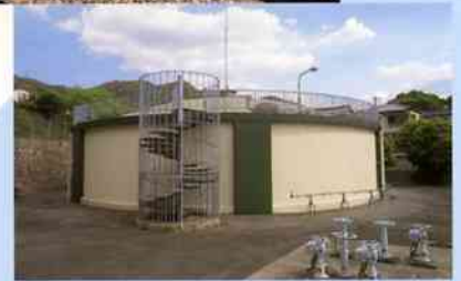
●石切低区浄水場
