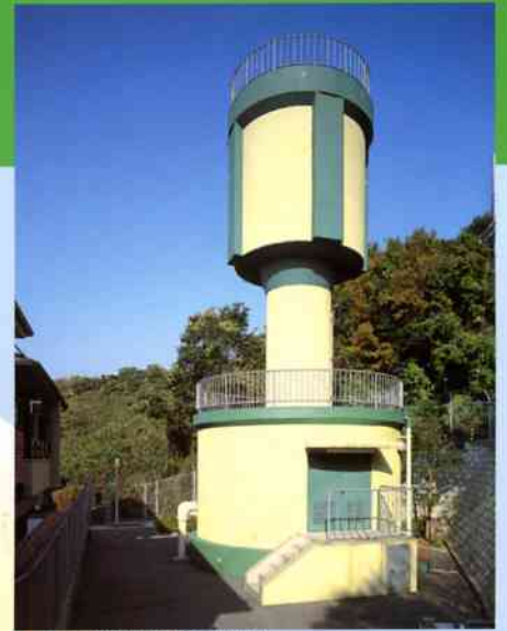
●山手町特別高区配水池
