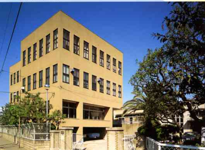
●菱屋西配水場
