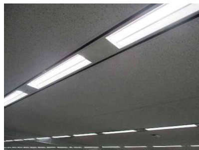
本庁舎の照明LED化
