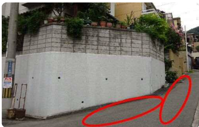
障害者入所施設建設事業用地（道路）①（令和 2 年 9 月 20 日撮影）
