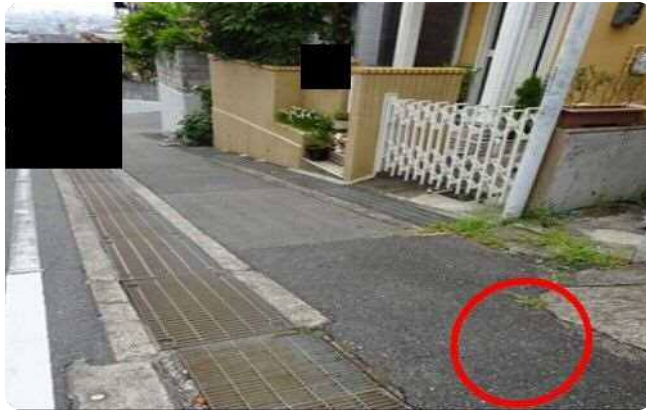
障害者入所施設建設事業用地（道路）②（令和２年９月２０日撮影）
