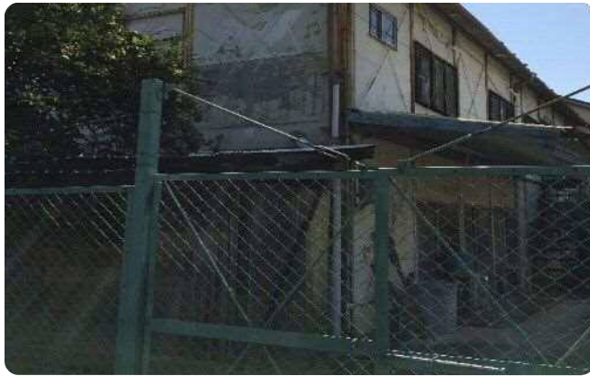
中小阪倉庫②（令和２年１０月２日撮影）
