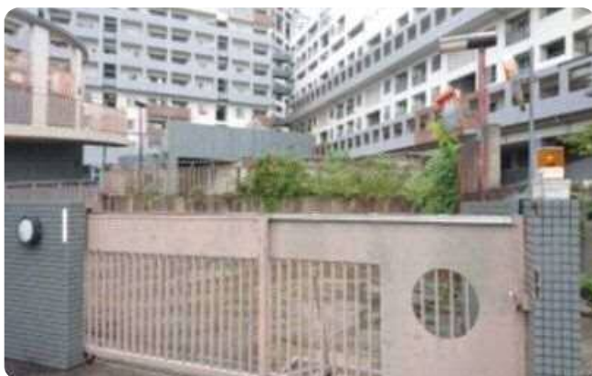
旧春宮保育所（防災関連倉庫）①（令和2年10月8日撮影）
