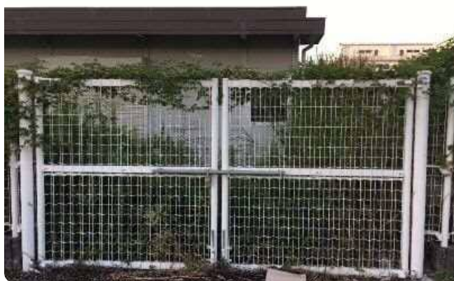
英田倉庫（空地 169 号地残地）①（令和 2 年 10 月 2 日撮影）
