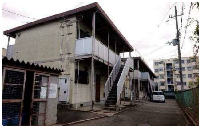
北蛇草住宅仮設住宅A（令和2年11月11日撮影）
