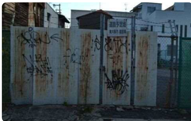
足代荒川線事業用地（３）①（令和２年１１月４日撮影）
