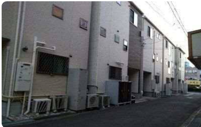
残地大阪瓢箪山線道路②住宅側（令和２年１１月４日撮影）
