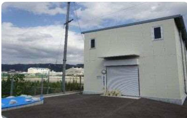
水防倉庫（土地を貸し付けている。）（①の西側）②（令和 2 年 10 月 5 日撮影）
