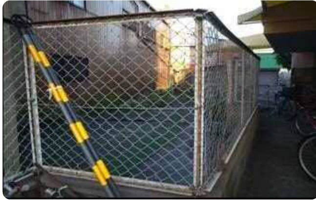
足代荒川線事業用地（２）②（令和２年１１月４日撮影）
