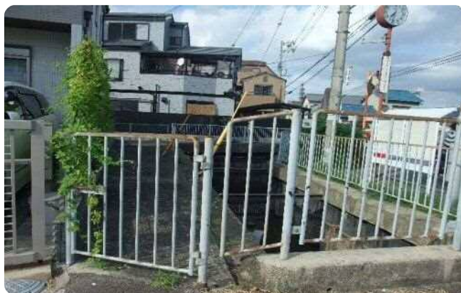
加納二丁目市有地（空地 87 号地）（令和 2 年 10 月 5 日撮影）
