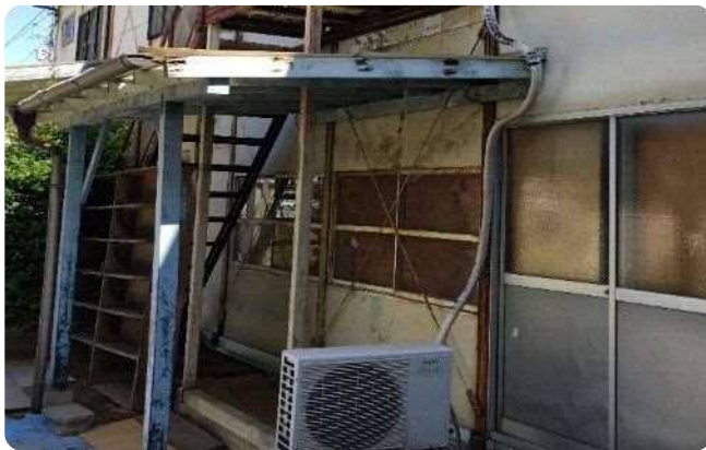
中小阪倉庫③（令和２年１０月２日撮影）
