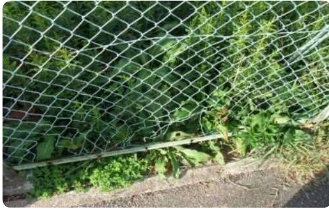
中地区消防署建設用地②（令和２年１０月５日撮影）
