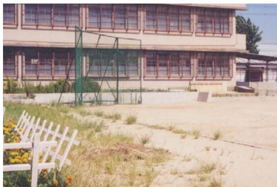
校庭貯留施設
