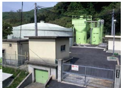
石切高区浄水場
