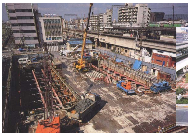
八戸ノ里駅前雨水貯留施設施工状況
