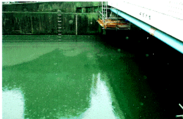
雨天時に高井田ポンプ場から平野川分水路へ放流される下水
