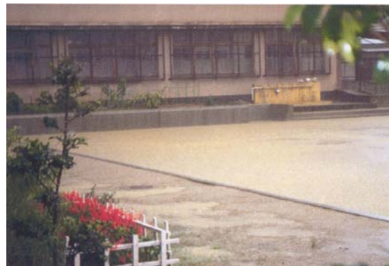
校庭貯留施設（貯留状況）
