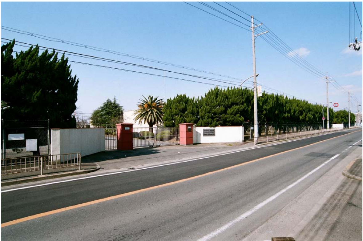
清掃センター新田事業所① 正面から北西側部分
