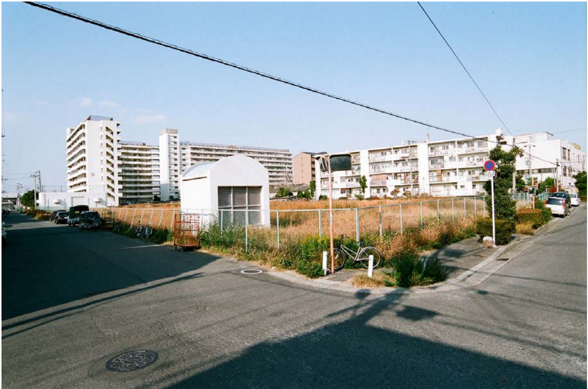
長瀬調節池① 南東側から北西側に向かって
