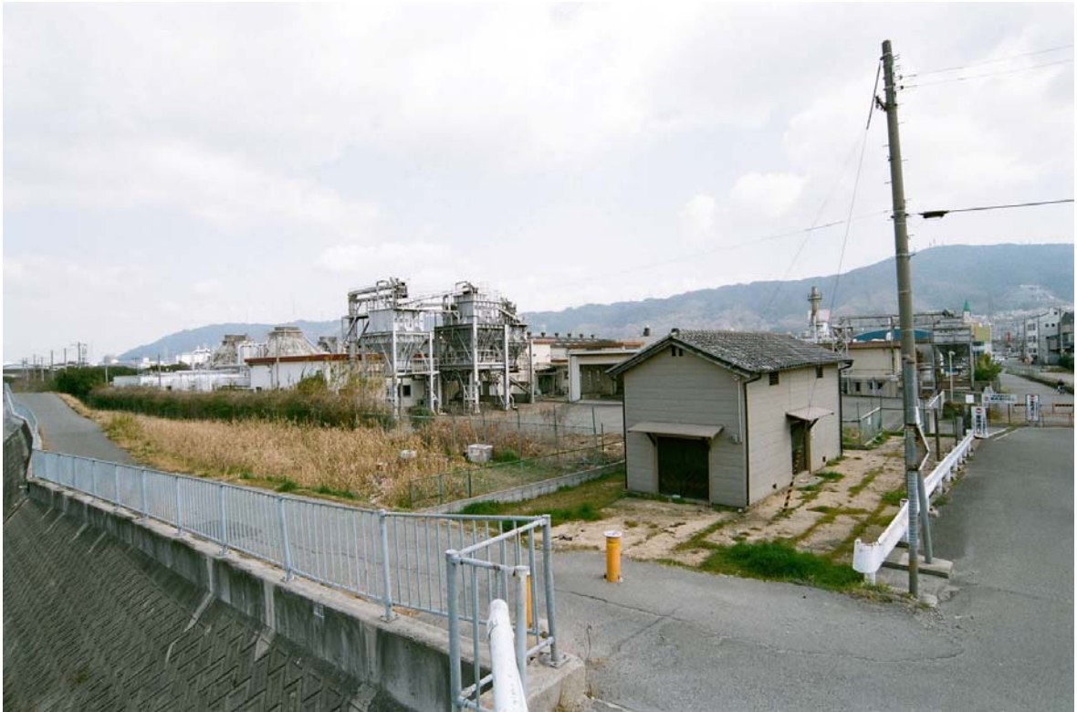
清掃センター東事業所 恩智川側から北東側に見える旧施設の敷地 (手前の水防倉庫は含まれない)
