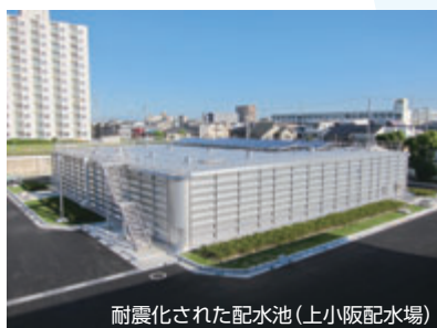
耐震化された配水池（上小阪配水場）
