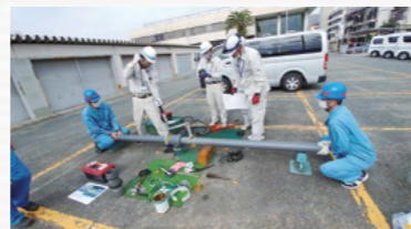
水道管接合実技研修の様子
