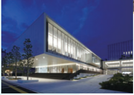
曲線部などにもライン照明が設置された大ホール(右)
