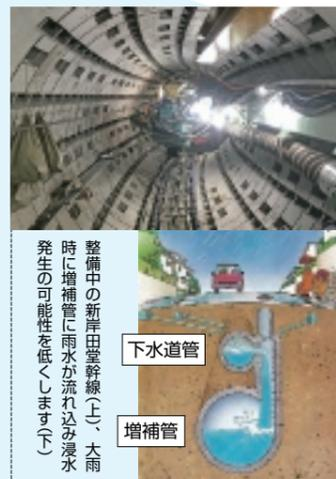
整備中の新岸田堂幹線(上)、大雨時に増補管に雨水が流れ込み浸水発生の可能性を低くします(下)
