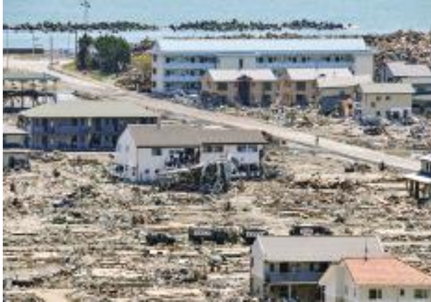
平成23年3月11日に発生した東日本大震災により、大きな被害を受けた被災地(上、右下)
