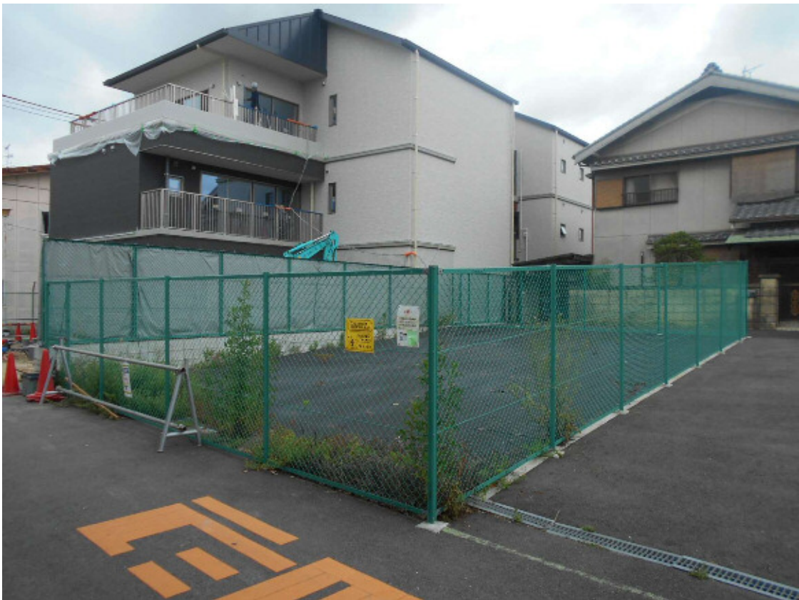
物件北西から南東に向けて撮影
