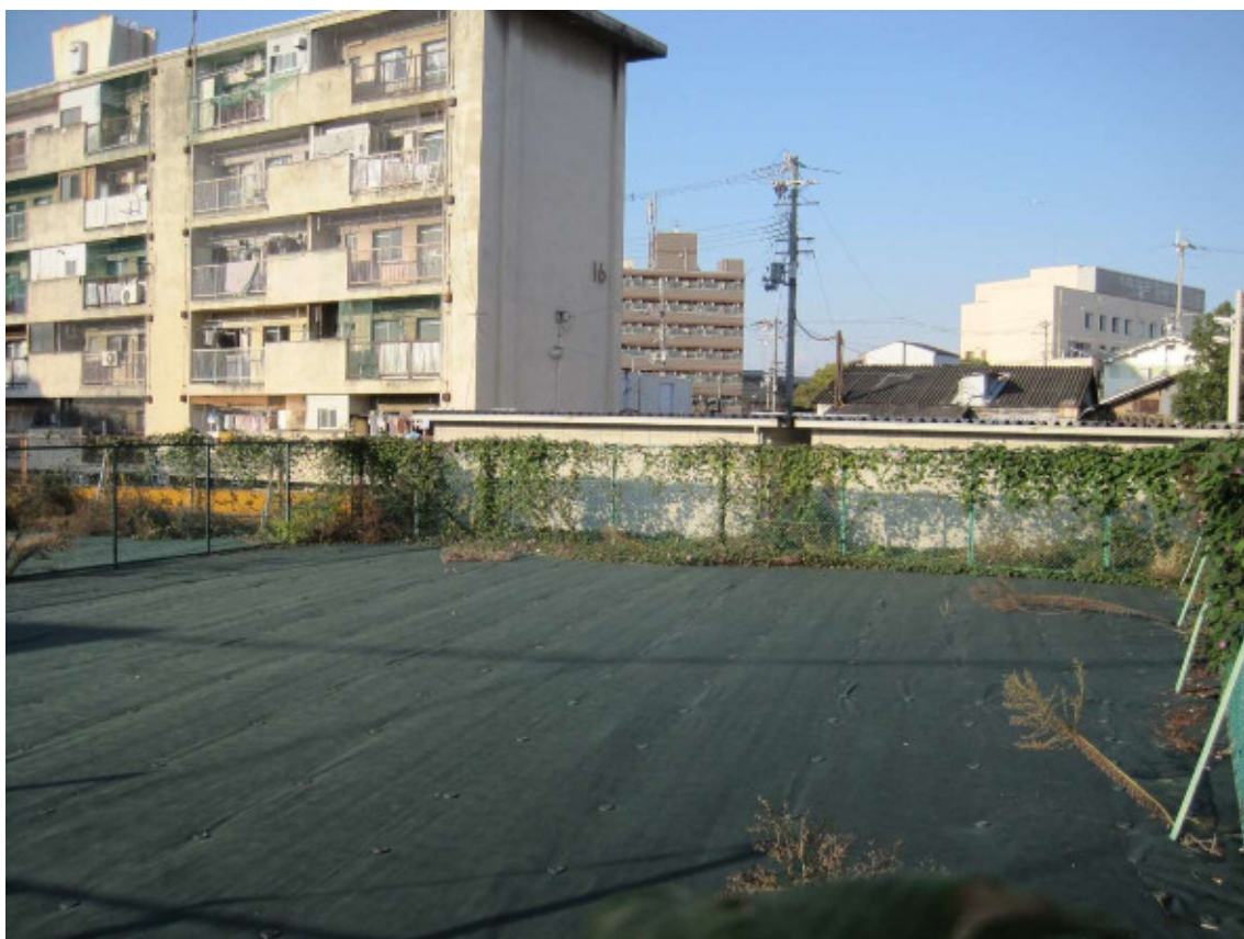
物件南東から北に向けて撮影
