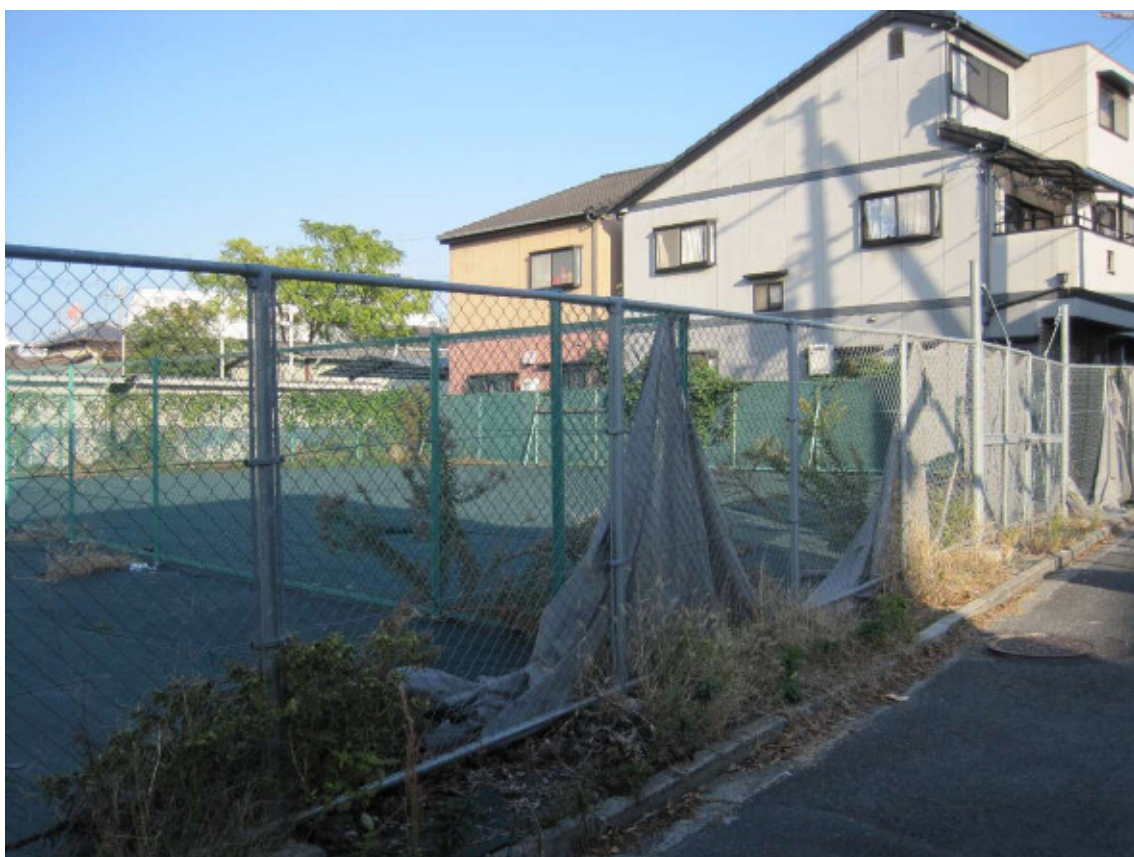
物件南西から北東に向けて撮影
