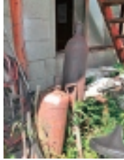
屋外に放置され、サビだらけになったボンベ
