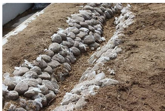
土止めの土嚢
