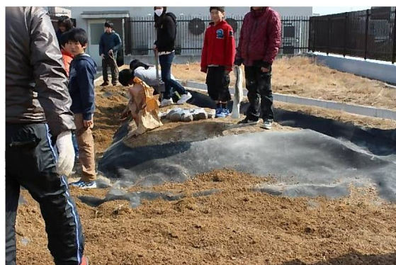
耐荷重の関係でポリエチレンシートを使用
