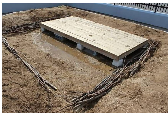
ウッドデッキ作成と設置
