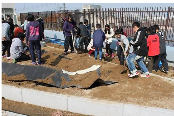
シートを敷いて土を被せる
