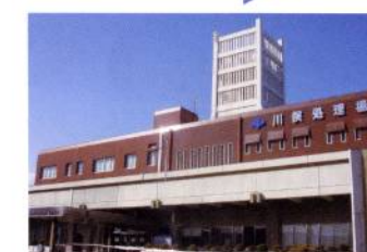
● 川俣水みらいセンター
