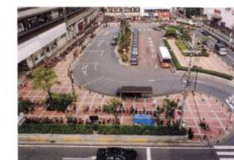
● 八戸の里雨水貯留施設
