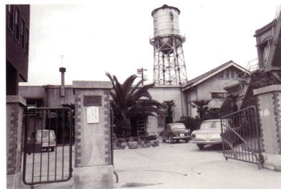
● 昭和42年 菱屋西浄水場
