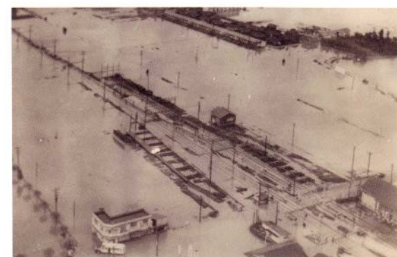
● 昭和33年 八戸ノ里駅周辺 浸水被害状況
