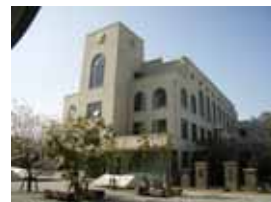
大阪商業大学・谷岡記念館(登録文化財)は、昭和初期の旧本館を移転・復元したもので、大学キャンパスのシンボルになっており、地域に開かれた施設としても活用されています。
