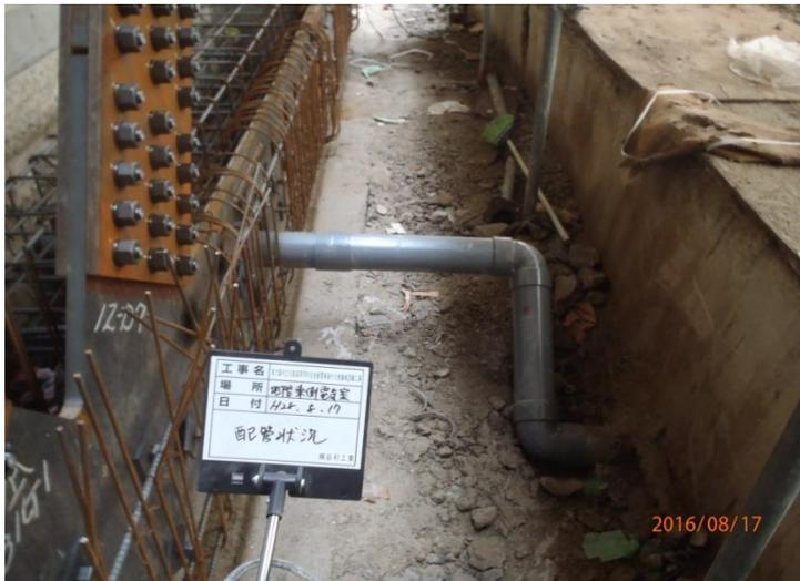
12棟東側地階の排水管接続状況である。建物から屋外へ配管された地中埋設排水管を一度切断し、既設建物へ耐震ブレースを設置後、再度接続を行った。
