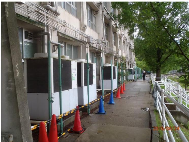
25棟GHP室外機置場の現状写真である。25棟は敷地内中央にあり東西に長い校舎となっている。この室外機は普通教室系統のもので移設し仮設使用後、撤去となる。フェンス撤去が完了し移設準備中を撮影したもの。
