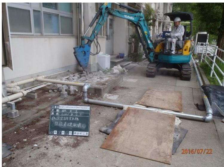
25棟GHP室外機の移設(写真右奥)を行い、各種配管を仮設接続し(写真はガス配管)夏休みまでの間、仮設で冷房運転を行う。写真は既設室外機基礎の撤去状況を撮影したものである。撤去後、建築工事にて耐震補強のための掘削工事を行う。
