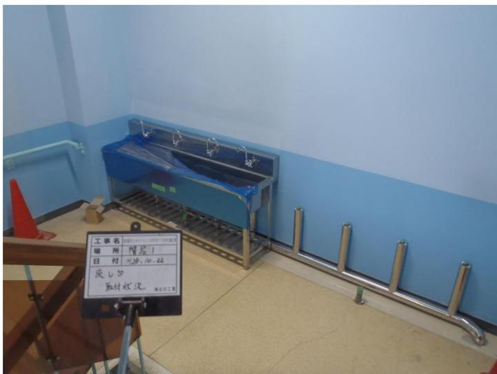
12棟西側の階段踊り場にSUS製流し台設置及び給排水管施工中の写真である。以前は窓付きの壁であったが、撤去して耐震壁を新設したため、既設手洗い場も同時に撤去となり、SUS製の手洗い流し台を設置した。右側にもう1台設置される。
